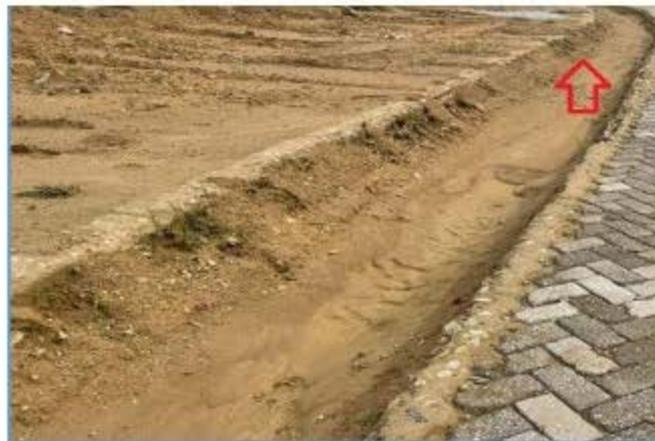
*para la fecha de realización de la visita del presente seguimiento, no se evidencio instalación del dispositivo de lavado de llantas, así como tampoco se evidencio que las cunetas o canales perimetrales estuviesen revestidos tal y como se indicó estaba proyectado a realizar.*
